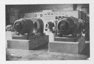
Fig. 21. — Poste d'émission. Au premier plan groupes convertisseurs ; à l'arrière-plan tableau de commande.
