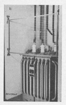
Fig. 22. - Transformateur d'injection.
