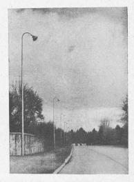
Fig. 6. — Luminaires à optique directrice, montés sur candélabres en tube de fer. Alimentation du secteur par câble souterrain.
