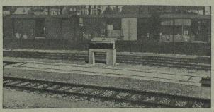
Pont à bascule pour chemins de fer. Capacité de pesage de 70 tonnes. Type normal des CFF avec pont en béton armé à nervures, longueur 11,6 m, construction légère Giroud, permettant le passage de locomotives d'un poids de 120 tonnes.
