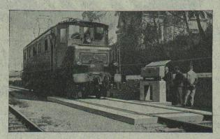
Pont à bascule de 40 ton. pour chemin de fer, permettant le passage de locomotives d'un poids de 130 ton.
