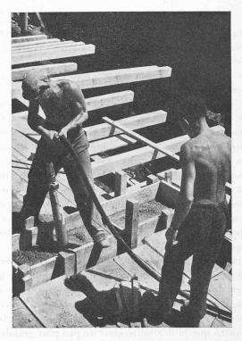
Pervibration du béton.
