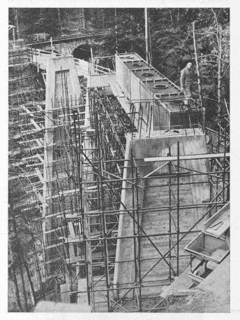
A. Détraz. Echafaudage tubulaire avec essai de charge d'une poutre triangulée au moyen de bacs remplis d'eau.
