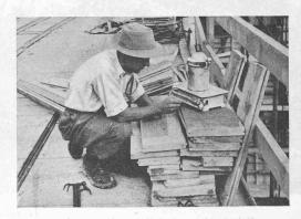
Contrôle de la quantité d'eau par la densité du béton frais.
