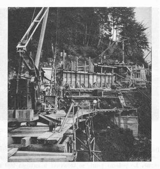
Installations pour la fabrication du béton. Au fond les silos à agrégats comportant quatre compartiments avec goulottes de sortie. Au centre, la bétonière. Au premier plan, la grue avec benne suspendue transportant le béton à son lieu d'emploi sans aucun transvasage.
