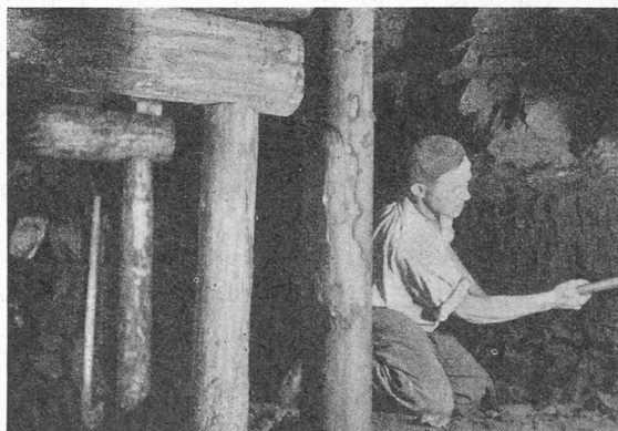
Fig. 11. — Dépilage des longs piliers.
