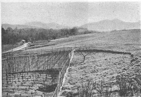
Fig. 8. — Vue prise en mars 1944, vers l'ouest, au-dessus de la galerie principale. Cirque d'effondrement circulaire de 40 m. de diamètre avec un trou vertical de 2 m de diamètre. Au fond, les affaissements graduels de la région extrême ouest de la mine, exploitée avec la méthode des longs piliers.
