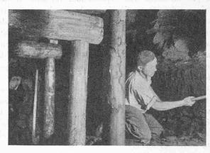
Fig. 11. — Dépilage des longs piliers.
