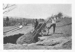
Fig. 9. — Remblayage des trous en surface. Remarquer la fissure limitant les affaissements au S.-W., à 10 m des murs de soutènement et exactement au-dessus de la limite du dépilage.
