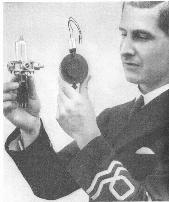
Fig. 11. — A droite, magnétron fournissant des puissances d'impulsion de l'ordre de 200 kW sur la longueur d'onde de 10 cm. A gauche, klystron à réflexion (dit tube de Sutton) utilisé comme oscillateur auxiliaire du récepteur. Le développement du tube à magnétron avec des puissances d'impulsion atteignant 1000 kW, de construction extrêmement condensée, ainsi que du klystron à réflexion ont constitué la base de la fabrication d'appareils Radar.
