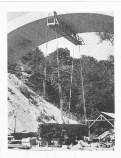
Fig. 20. — Essai de charge.
