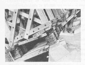
Fig. 11. -- Détail de l'appui d'un cintre.
