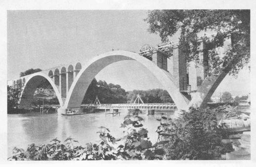
Fig. 17. — Vue générale de la superstructure en construction.
