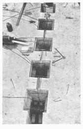
Fig. 45. — Logements des presses de la voûte sur le Rhône. On distingue les plateaux de chêne dans les joints et les barres en attente qui seront soudées après le clavage.
