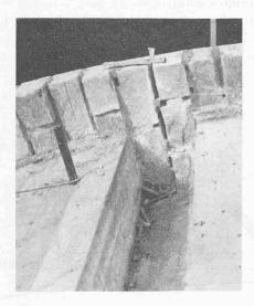
Fig. 14. — Détail d'un joint de retrait d'une voûte.
