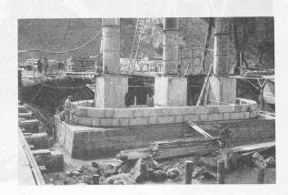
Fig. 7. — Fonçage de la pile II.
