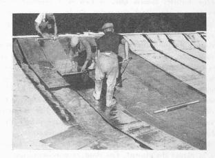
Fig. 5. — Pose de la chappe d'isolation du tablier.
