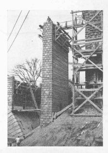
Fig. 16. — Construction d'une pile secondaire.
