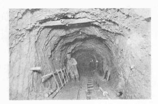
Fig. 6. — Percement de la galerie à l'amont du puits de visite.
