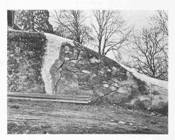
Fig. 7. — Chancy. Mur déformé par les glissements de terrain, rive suisse.
