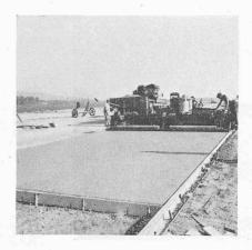
Fig. 8. — Machine Lakewood pour le réglage, le damage et le surfaçage du béton.
