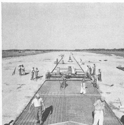
Fig. 9. — Le bétonnage de la dalle.
