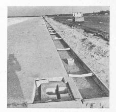
Fig. 13. — Gondole bordant la piste et logement d'un plot de signalisation lumineux.
