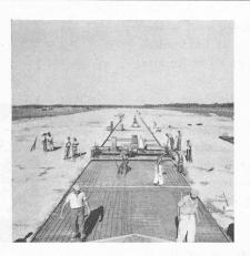
Fig. 9. — Le bétonnage de la dalle.
