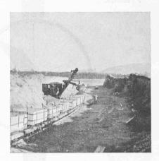
Fig. 11.—Pelle travaillant en tranchée, au Renard.
