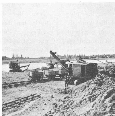
Fig. 5, 6 et 7. — Pelles mécaniques.
