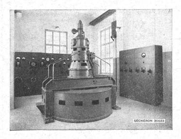
Centrale hydro-électrique de la fabrique de draps F. Hefti & Cie à Haetzingen (Glaris). Sécheron a fourni l'alternateur 430 kVA, 525 V, 50 pér/s, 428 t/mn, les tableaux de manœuvre avec réglage automatique ainsi que les transformateurs.
