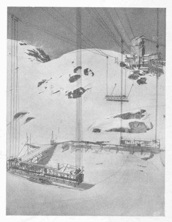
Fig. 4. — Le chantier en avril 1944 et les installations de bétonnage.
