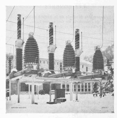
Fig. 16. — Disjoncteurs pneumatiques ultra rapides de Brown, Boveri.
