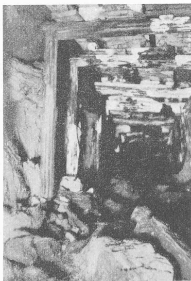
Fig. 21. — Ecrasement des flancs d'une galerie de mine trop faiblement étayée. Mine de lignite de Grandson.
