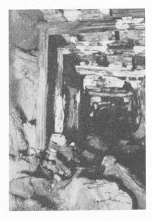
Fig. 21. — Ecrasement des flancs d'une galerie de mine trop faiblement étayée. Mine de lignite de Grandson. Cliché A. Dunant.
