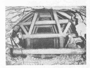
Fig. 5. — Tunnel du Simplon. Boisage de la galerie de faîte et de la calotte dans les gneiss d'Antigorio lités horizontalement. Remarquer le nombre et les dimensions des étais horizontaux.
