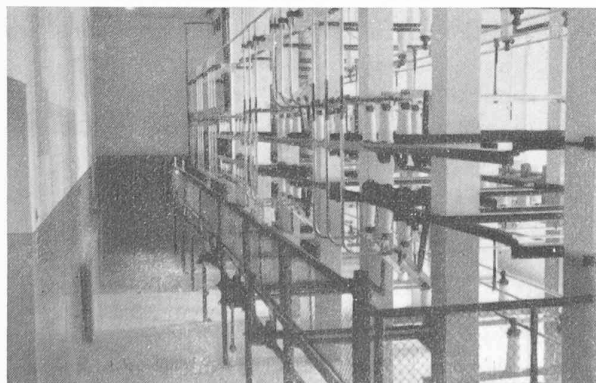
Fig. 10. — Sectionneurs et barres 13 kv.
