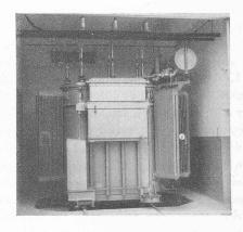
Fig. 6. — Transformateurs à gradins de 3500 kv.
