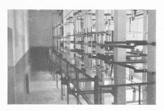
Fig. 10. — Sectionneurs et barres 13 kv.
