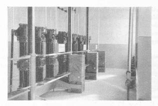
Fig. 7. — Disjoncteur 40 kv à faible volume d'huile,
