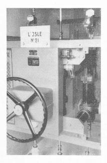
Fig. 9 a. — Disjoncteur 13 kv à faible volume d'huile. Vue de face.
