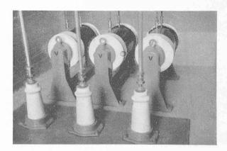
Fig. 11. — Transformateurs de tension 13 kv, à sec.
