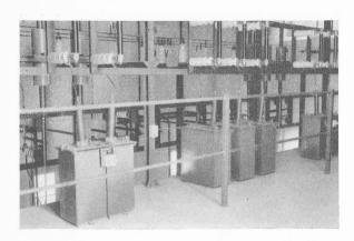
Fig. 8. — Barres et transformateurs de tension 40 kv.
