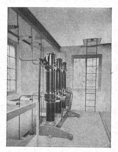
Disjoncteur à faible volume d'huile. Type HP 9 - 60 kV - 750 MVA. Type fourni pour le poste transformateur Marcelin s/Morges de la Compagnie vaudoise des forces motrices
