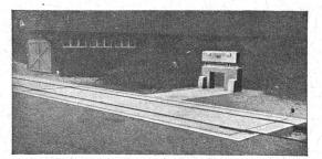
Pont à bascule de 40 ton. pour chemin de fer, avec pont en béton armé, système de leviers sans torsion, couteaux réglables.
