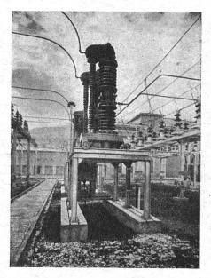
Disjoncteur type HPFa 64 hV 750 mVA
