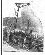
La petite grue RACO, exécution brevetée, se distingue par certains avantages qui se font déjà valoir lors du montage et tout particulièrement pendant le service. Son montage pour le travail prévu se fait en quelques instants et la transformation de la portée, de la hauteur d'élévation et de la force portante au gré des besoins, ne demande que quelques minutes. La construction de la petite grue RACO est solide et elle lui garantit une longue durée d'existence.
