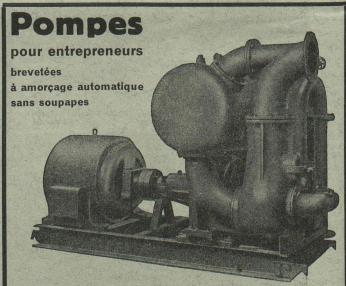
Hauteur d'aspiration jusqu'à 9 mètres, débits de 1 à 500 litres/ seconde. — Pas de soupape de pied, ni de clapet dans la tubulure d'aspiration. Aucune pompe à vide de secours. — Réamorçage automatique immédiat, même si de l'air est entré dans le tuyau d'aspiration. - Pas d'organes présentant des frottements et s'usant, par conséquent insensibilité à l'action des schlamms, du sable et des graviers.
