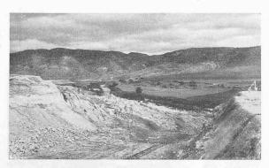
Fig. 40. — Grand glissement au débouché du canal de fuite dans l'Oued-el-Hammam.
