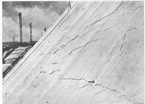
Fig. 25. — Déformation du parement amont.
