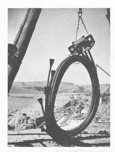
Fig. 30. — Déchargement d'un tirant métallique de 1000 tonnes.
