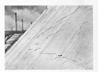
Fig. 25. — Déformation du parement amont. Décollement de la couche de béton poreux d'égalisation. Cliché P. et C.
