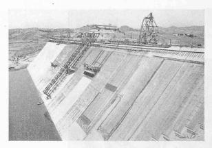
Fig. 35. — Exécution du masque en béton bitumineux. Au premier plan le béton d'égalisation avec ses joints de dilatation. Par dessus le grillage d'armature du béton bitumineux. Plus loin les fils d'armature continus du masque de protection. Au fond le masque est terminé.
