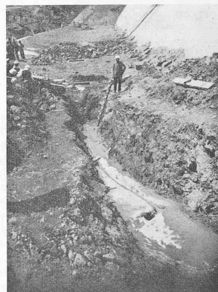
Fig. 36. — Avarie au tapis d'étanchéité composé de sept couches de toiles enduites de « Flintkote ».
