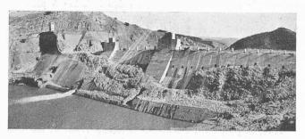
Fig. 1. — Ancien barrage de l'Oued Fergoug après la crue de 1927. La brèche a été partiellement fermée et consolidée par des tirants, dont on aperçoit les têtes en béton.
