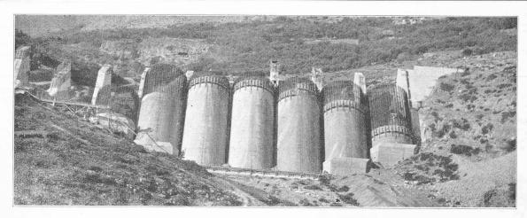
Fig. 3. — Barrage-voûte de Beni-Bahdel. Vue d'amont. Ouverture des voûtes 20 m.
