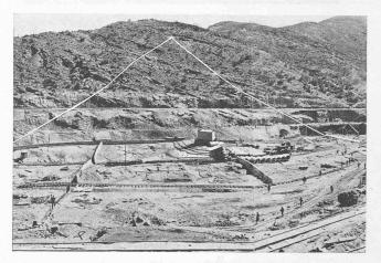
Fig. 11. — Les terrains de fondation avec l'emprise du barrage et les premiers éléments du filtre : drains et murettes.
