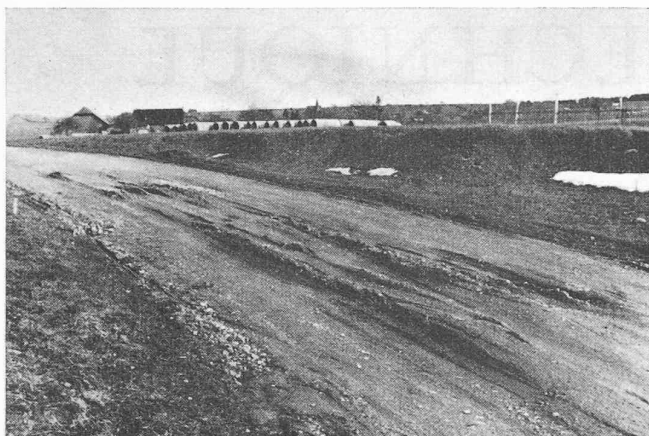
Fig. 1. — Type de chaussée ordinaire (non revêtue) fondée sur sol glaiseux-sableux, détruite par le gel de l'hiver 1941-1942.
