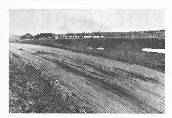
Fig. 1. — Type de chaussée ordinaire (non revêtue) fondée sur sol glaiseux-sableux, détruite par le gel de l'hiver 1941-1942.
