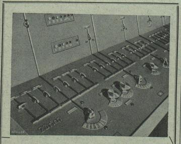
Installations de commande à distance et de signalisation en retour pour usines électriques
