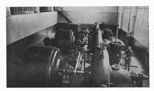
Société hydro-électrique des Dranses. Usine de Bioge (Haute Savoie). 3 alternateurs triphasés 3800 kVA, 6000 V, 50 pér/s accouplés à des turbines de 3800 ch ; ces alternateurs tournent à la vitesse de 1000 t/mm. Vitesse d'emballement : 1900 t/mm.
