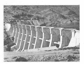
Fig. 2. — Barrage des Beni-Bahdel, près de Tlemcen (Algérie). Barrage à voûtes multiples de 20 m de portée; sommet des contreforts préconcentraint suivant les procédés Erryssinet.
