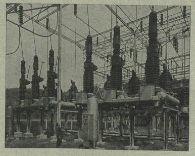
Disjoncteurs pneumatiques ultra-rapides de 150 kV pour montage à l'extérieur dans une installation en Suisse.
