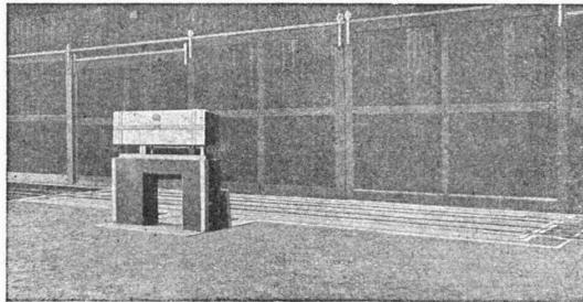
Pont à bascule de 40 ton. pour chemin de fer, avec pont en béton armé, système de leviers sans torsion, couteaux réglables.
