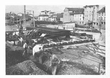
Fig. 5. — Pont de Fribourg. Essai de charge.
