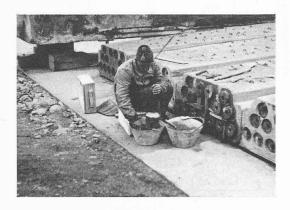
Fig. 4. — Pont de Fribourg. Cônes d'ancrage femelles scellés dans niches ménagées à l'extrémité des poutres.
