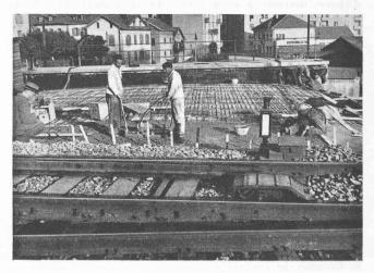
Fig. 7. — Pont de Fribourg. Bétonnage de la dalle mince de liaison.
