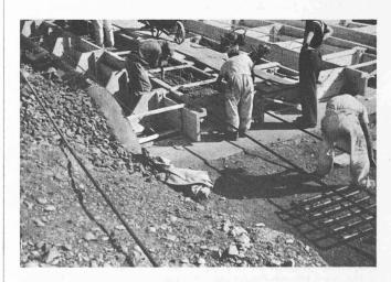
Fig. 2. — Pont de Fribourg. Bétonnage d'une poutre. Tubes d'acier retirés après la prise du béton pour réaliser le logement des câbles.
