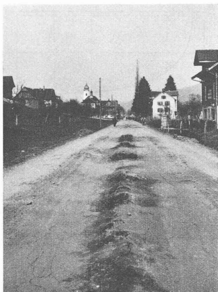
Fig. 1. — Dégâts provoqués par le gel dans un revêtement bitumineux près d'Ebikon. Les traces de roues sont imprimées dans la chaussée dont le milieu est fortement refoulé vers le haut. Etat après l'apparition du dégel. (Photo O. Enzmann, ing. cant.)
