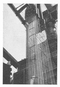
Fig. 9. — Poutrelle d'essai nº 2. Armatures tendues avant bétonnage.
