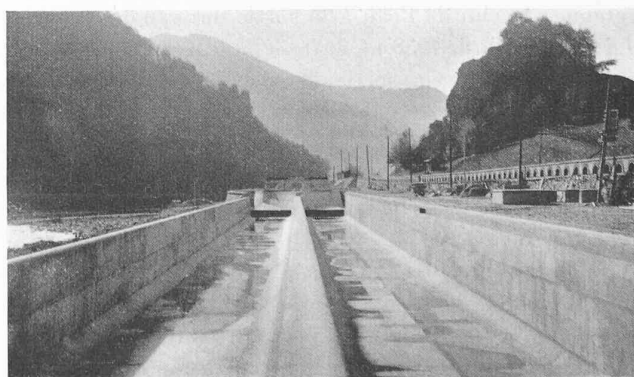
Fig. 8. — Canaux intermédiaires avec, au fond, les diaphragmes et le départ des canaux latéraux.
