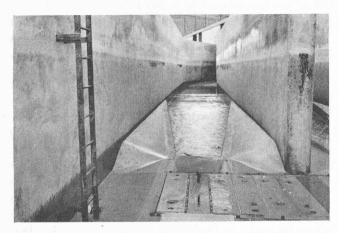
Fig. 7. — Dégraveur avec ses deux seuils, son orifice de purge et la couverture de sa fosse, vus de l'aval.
