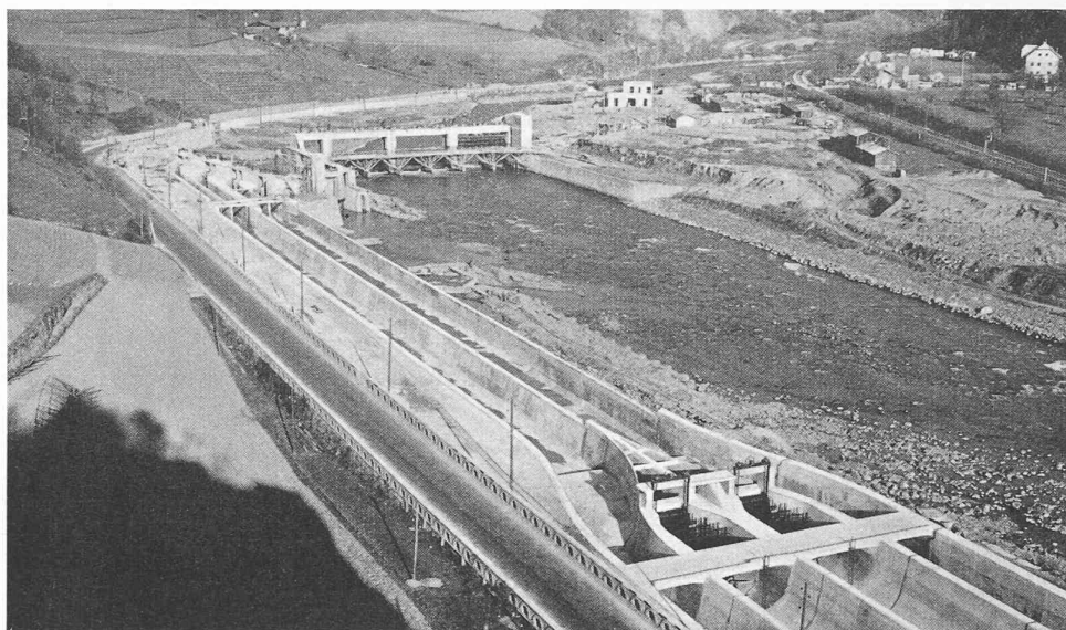
Fig. 9. — Vue sur l'entrée des dessableurs et des canaux latéraux, sur les diaphragmes, les canaux intermédiaires, avec, au fond, les dégraveurs, la prise d'eau et le barrage.
