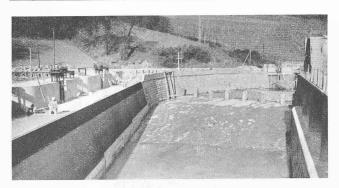
Fig. 5. — Chenal de chasse avec fond en dalles de porphyre, grille et yannes d'entrée.
