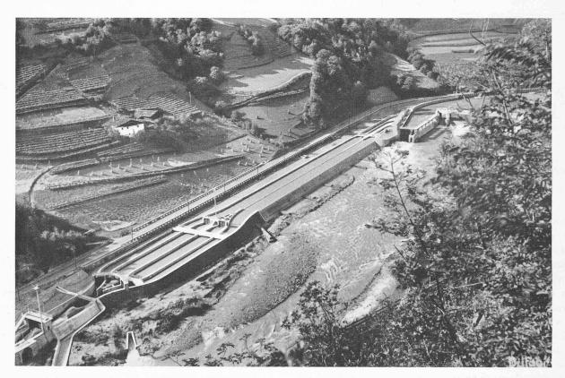
Fig. 4. — Vue sur l'ensemble de l'installation. Bassin versant du torrent env. 3000 km². Débit dérivé 100 m³/sec.
