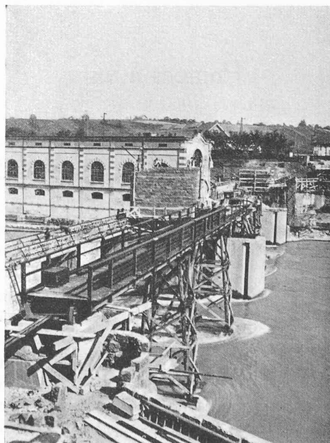
Fig. 5. — Passerelle provisoire au montage (tronçon rive gauche).
