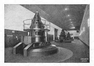
La nouvelle centrale souterraine d'Innertkirchen, équipée actuellement avec trois, dans l'étape définitive avec cinq alternateurs verticaux Oerlikon de 52250 kVA chacun.
