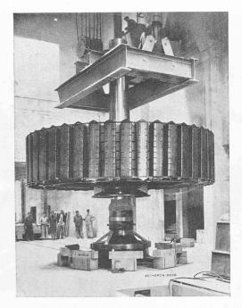
Fig. 53. — Rotor complètement monté.
