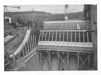
Fig. 35. — Coffrage et ferraillage du parement aval de l'écran du barrage.
