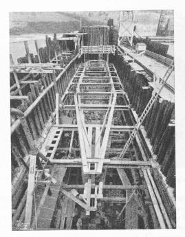
Fig. 21. — Enceinte de la pile III et son étayage.
