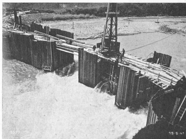
Fig. 33. — Fermeture du goulet de 45 m; passage de la phase I à la phase II.
