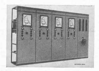
Fig. 70. — Tableau de commande du barrage.
