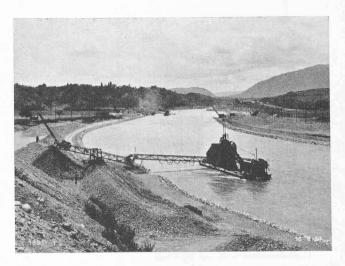
Fig. 14. — Vue d'ensemble des travaux de correction du Rhône. (A comparer à fig. 2.)
