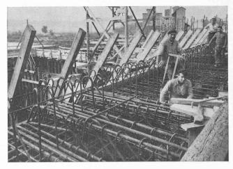
Fig. 25. — Ferraillage du plancher de la chambre des treuils.
