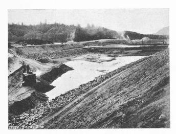
Fig. 12. — Exécution à sec des coupures des presqu'îles.
