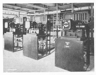
Fig. 69. — Régulateurs automatiques des alternateurs.
