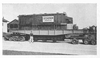
Fig. 61. — Transport sur route du transformateur 25 000 kVA.
