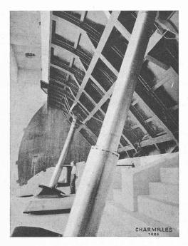
Fig. 41. — Vanne-clapet vue de dessous.
