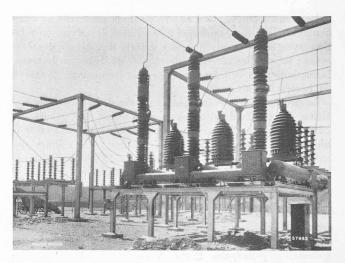
Fig. 64. — Disjoncteur 150 000 V à air comprimé en place dans la station extérieure.
