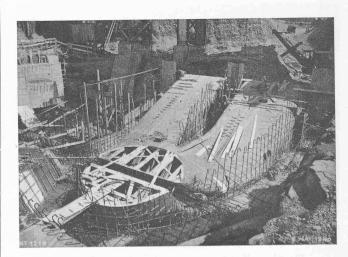
Fig. 28. — Coffrage du tube d'aspiration du groupe I.
