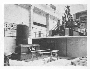
Fig. 55. — Vue d'ensemble de l'alternateur et du régulateur de la turbine, montés à Verbois.
