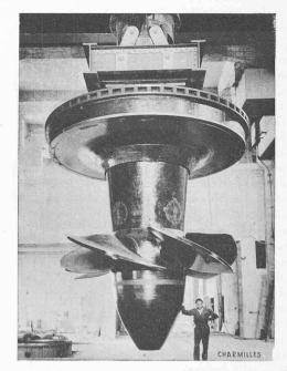
Fig. 47. — Roue Kaplan et son couvercle suspendus au pont roulant.
