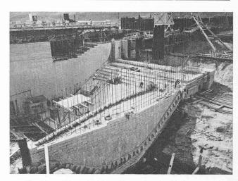
Fig. 24. — Bétonnage du radier et des piles du barrage.
