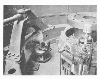
Fig. 48. — Intérieur du cuvelage de la turbine avec accouplement, carter des pompes, limiteur de vitesse, soupape d'entrée d'air et cercle de vannage.
