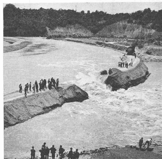
Fig. 13. — Ouverture de la digue amont de Cartigny.
