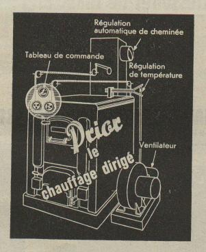
Votre chauffage central, avec l'installation complémentaire " **Prior**", brûle l'enthracite du Valais et les boulets valaisans sans mélange d'autres combustibles. Coke, tourbe, lignite, bois, sciure, etc. brûlent complètement.
