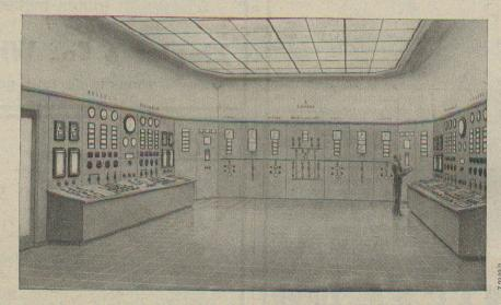
Galerie de commande commune pour la surveillance centralisée de la chaufferie, des machines et du poste de distribution dans une usine de force motrice à haute pression.
