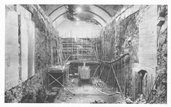
Fig. 16. — Exécution des revêtements de la salle des machines.
