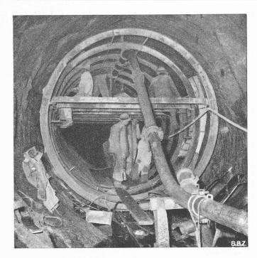
Fig. 10. — Le tuyau Φ 150 mm d'alimentation du béton est amené, à l'avancement, à la hauteur du faîte. On remarquera le cintre métallique du coffrage posé sur la voie de roulement.
