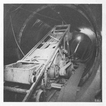
Fig. 9. — Exécution de la galerie d'amenée. — La pompe à béton et sa benne d'alimentation pour un débit de 7 m³/h; sous le plan incliné, le moteur de 30 ch de la pompe à béton.
