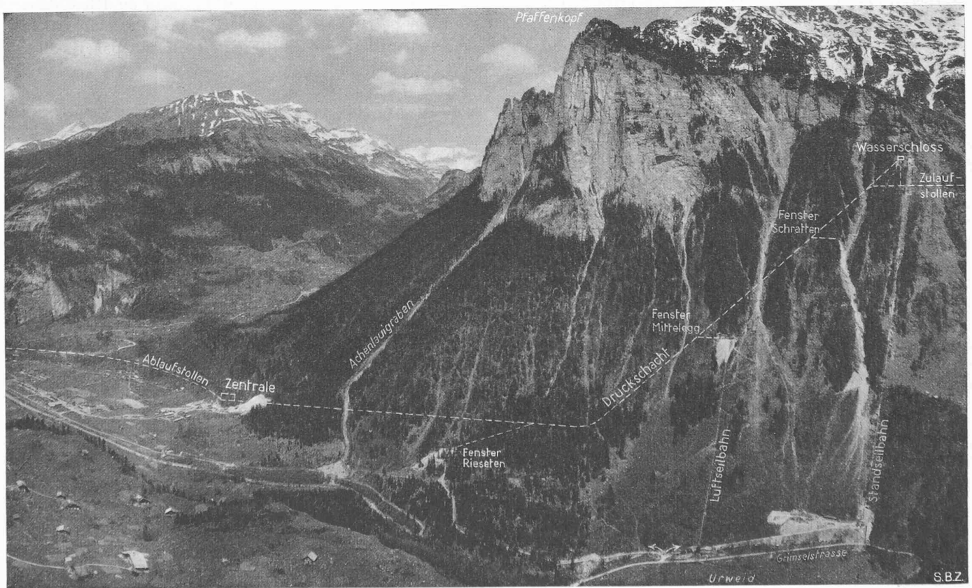
Fig. 5 — Vue d'ensemble des installations.
