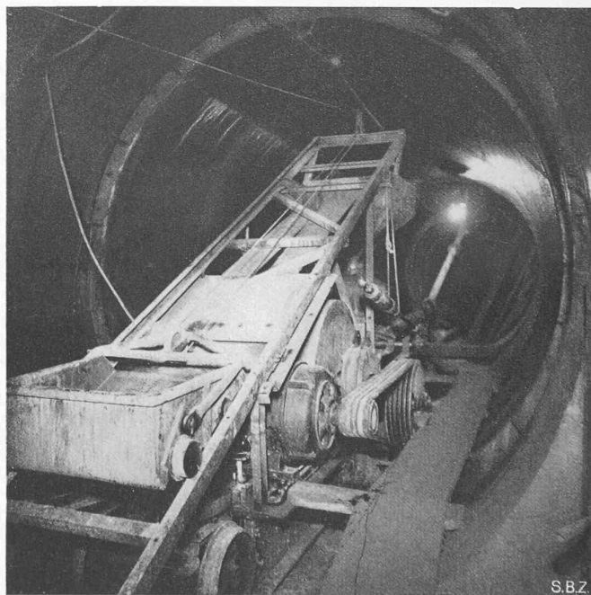
Fig. 9. — Exécution de la galerie d'amenée. — La pompe à béton et sa benne d'alimentation pour un débit de 7 m 3 /h ; sous le plan incliné, le moteur de 30 ch de la pompe à béton.
