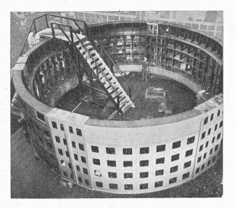
Les usines Siemens construisent pour l'usine hydroélectrique de Yalu, au Mandchoukouo, 4 alternateurs de 100000 kVA chacun, à 150 t/min. Ce sont les plus grands alternateurs pour turbines hydrauliques construits jusqu'ici en Europe. Leur hauteur totale est de 12,3 m. et leur diamètre de 9,8 m. Les segments du bâti sont assemblés à la soudure électrique.
