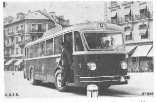
Fig. 7. — Le trolleybus nº 1 lors de sa première sortie (Place du Cirque, 26 juin 1942). Pendant les essais et avant que la ligne de contact soit installée, un seul trolley est en service; l'autre est relié aux rails de tramways par un petit chariot à deux essieux accouplé au trolleybus.
