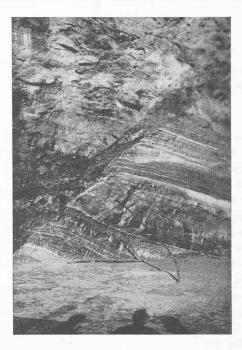
Cliché S: E. C: Rodio. Fig. 14. — Tracé de la faille sud à l'aplomb de la fouille H, rive droite.
