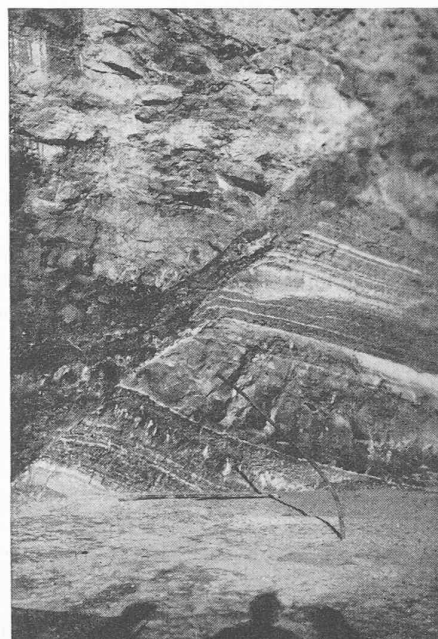
Fig. 14. — Tracé de la faille sud à l'aplomb de la fouille II, rive droite.
