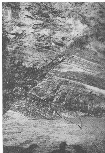
Fig. 14. — Tracé de la faille sud à l'aplomb de la fouille II, rive droite.
