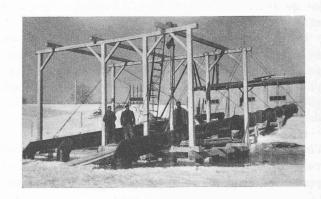
Fig. 4. -- Conduites d'aspiration et charpente-support.
