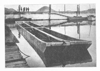
Fig. 8. — Ponton en tôle et profilés d'anticorodal.
