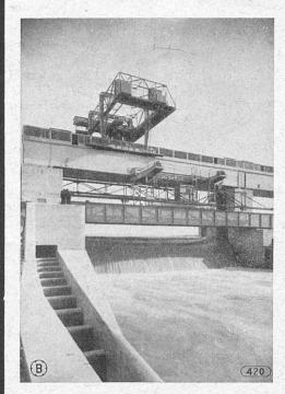
Barrage de Klingnau, vue du côté aval avec grues pour la mise en place des batardeaux.
