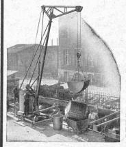
Tous les arbres d'engrenage de la petite grue RACO tournent dans des roulements à billes de précision et ne sont, de ce fait, soumis pratiquement à aucune usure. Le treuil et le moteur, montés dans une cabine de protection fermant à clef, sont d'un accès facile. Tout recul de la charge est rendu impossible par l'action de cliquets de sûreté et un frein à contrepoids. Un câble antigiratoire sert d'organe de levage et la poulie à câble peut servir pour l'élévation directe ou mouflée.
