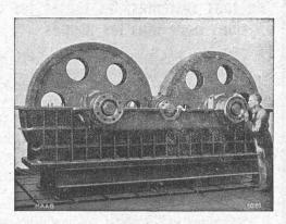
Réducteur de vitesse pour 3900 CV avec denture hélicoïdale rectifiée.
